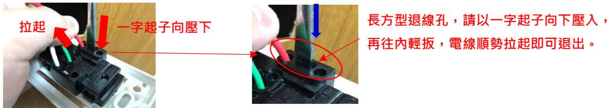
4. 取**雙USB+單接地插座組**，將3條原電源線分別插入**接線座孔**(電源線)及插座之插孔(設備接地線)內
